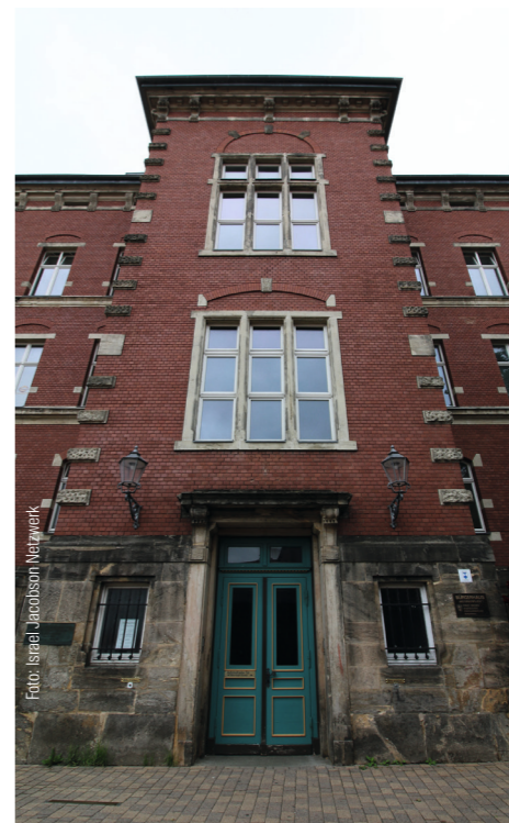
Das ehemalige Alumnat der Jacobsonschule und heutige Jacobsonhaus
